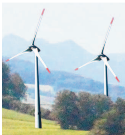
Windparks sollen bald im Baselbiet entstehen.
